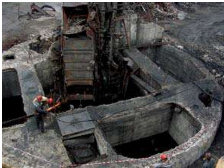
Рис. 11. Проходчики ШПСУ № 9 перекрывают аварийный ствол на шахте Бажанова, пострадавшей от боевых действий на территории Донецкой Народной Республики.
